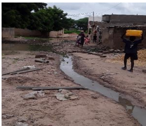
Photo 4 : Gestion des eaux
